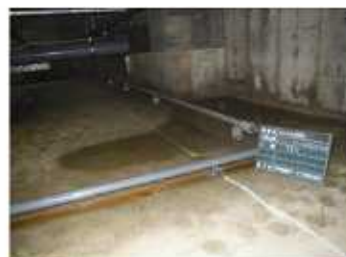
照片-8 排水沟配管改造后
