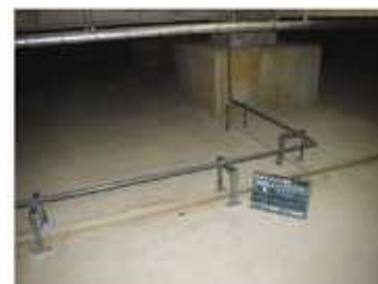
照片-10 排水沟配管改造后
