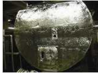
照片-11 锅炉端板隔热后
