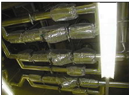
照片-13 蒸汽阀隔热后
