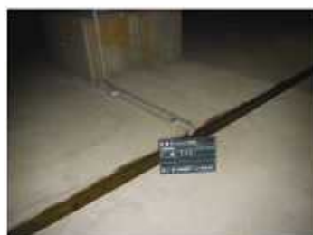
照片-9 排水沟配管改造前
