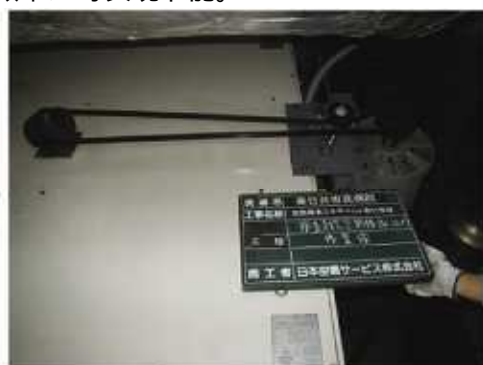
照片—18 安装平传动带后的空调机
