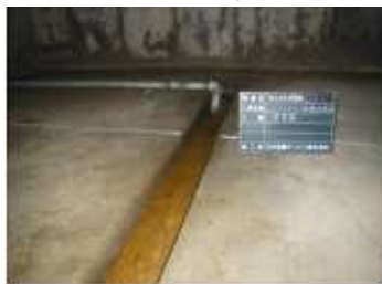
照片-7 排水沟配管改造前
