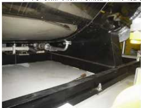
照片—15 锅炉底部隔热前
