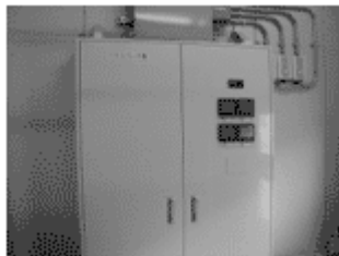
图-9 排气鼓风机控制盘
