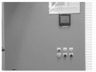
图-11 电动阀门开闭 SW
