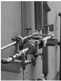
照片 8 汽水分离器与号码标签 的设置情况
